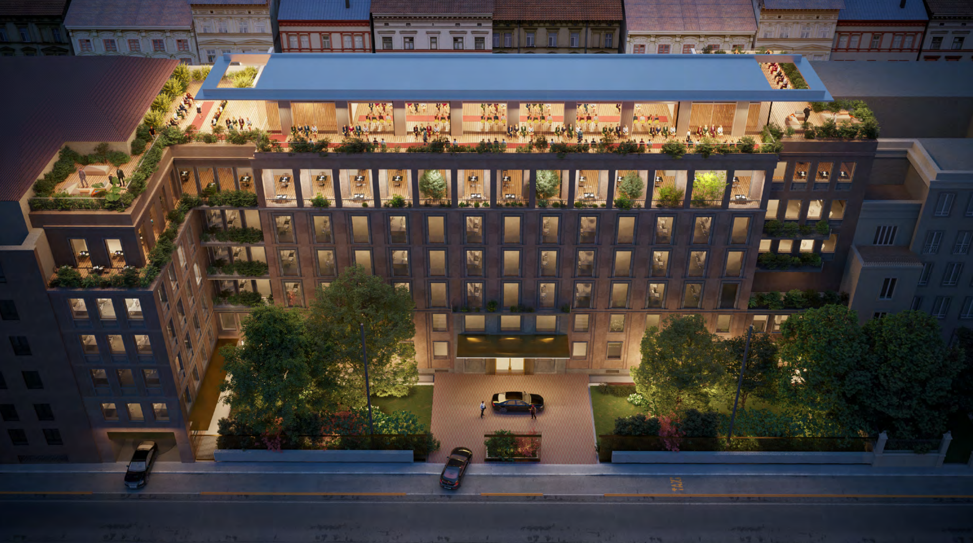
Facciata su via Senato, una delle strade più prestigiose di Milano. Sette piani fuori terra adibiti in larga parte a uso ufficio.
