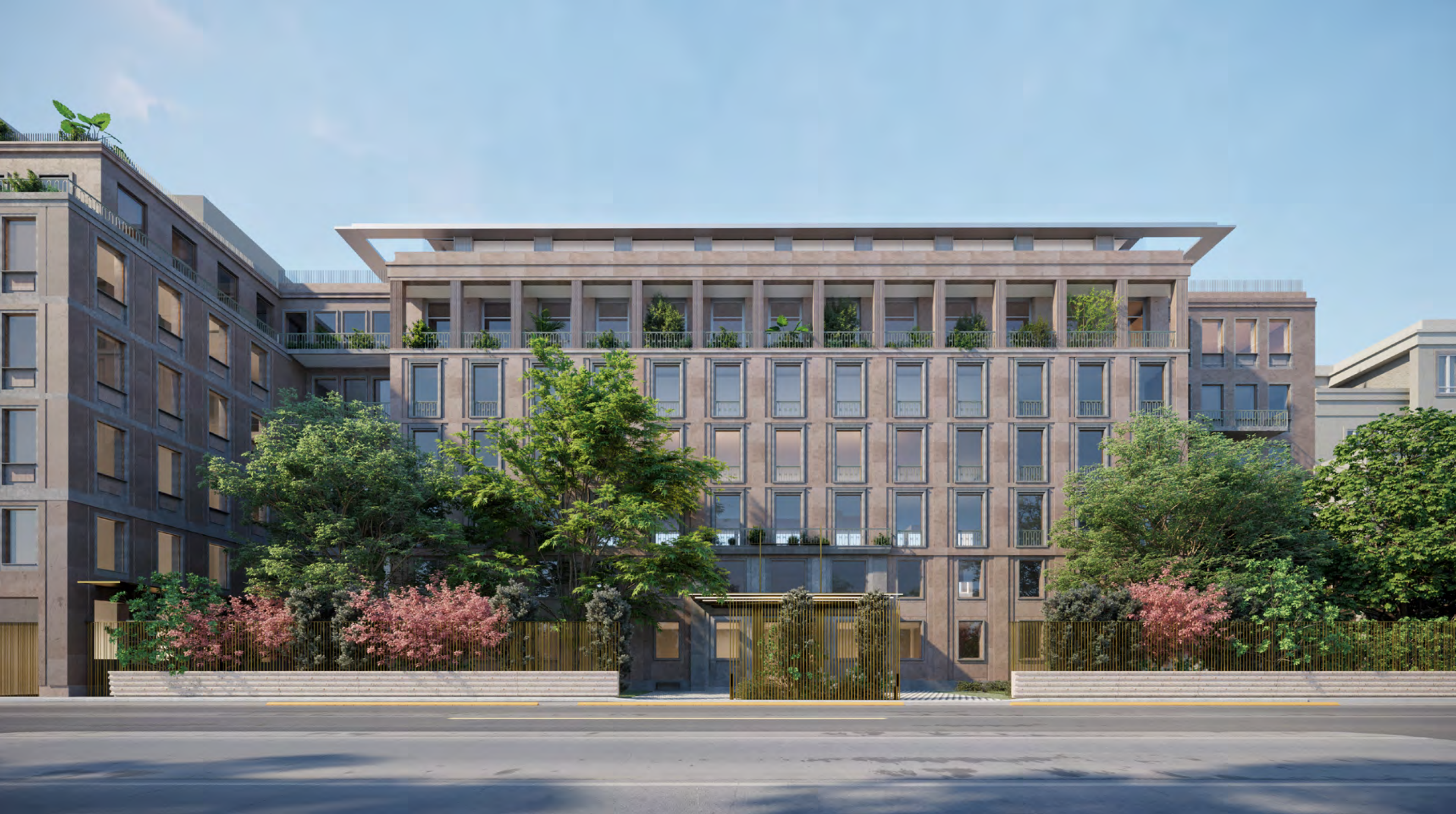
Facciata su via Senato, una delle strade più prestigiose di Milano. Sette piani fuori terra, adibiti in larga parte ad uso ufficio.
